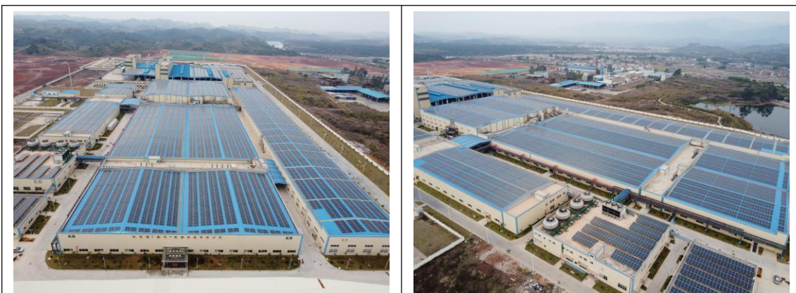
凯荣德 6MW 及忠信 1.72MW 屋顶分布式光伏发电项目
