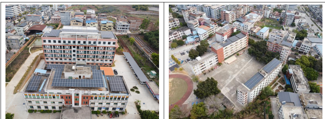
马市镇卫生院及中心小学 303KW 屋面光伏发电项目
