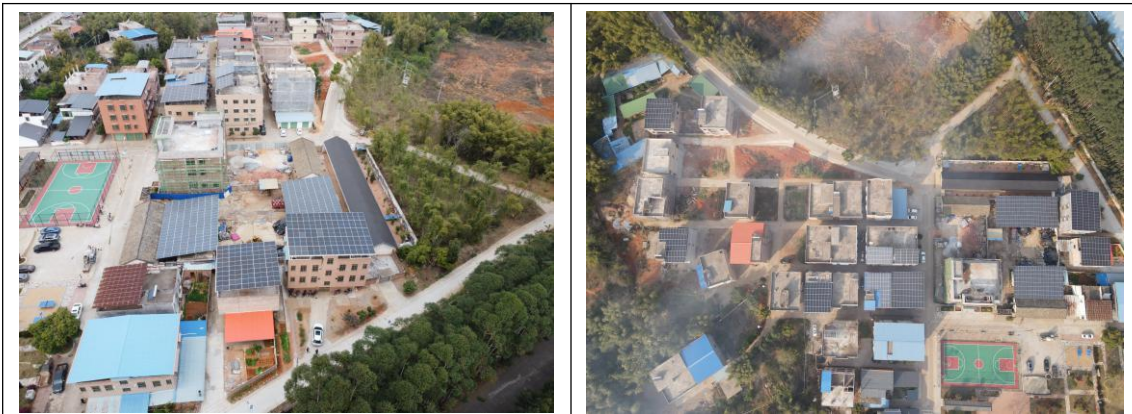
太平镇纱帽岗村居民屋顶分布式光伏发电项目
