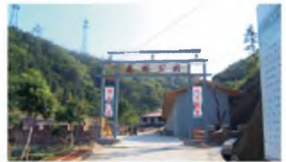
建设中的隘子镇森林公园
