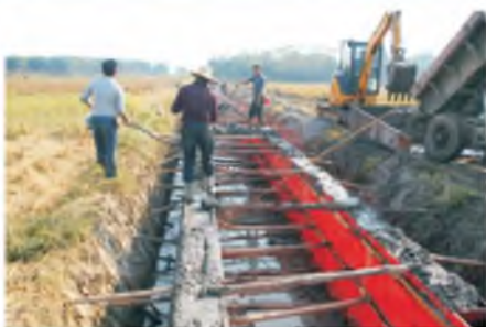
省级小农水重点县项目施工现场
