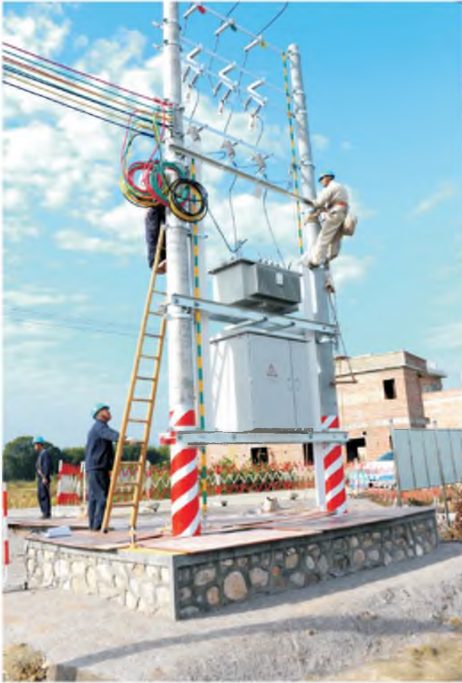
样板工程——顿岗新建寨下台区
