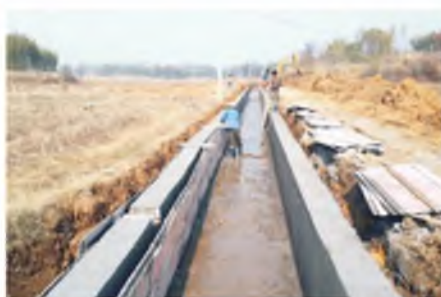
田间工程施工现场
