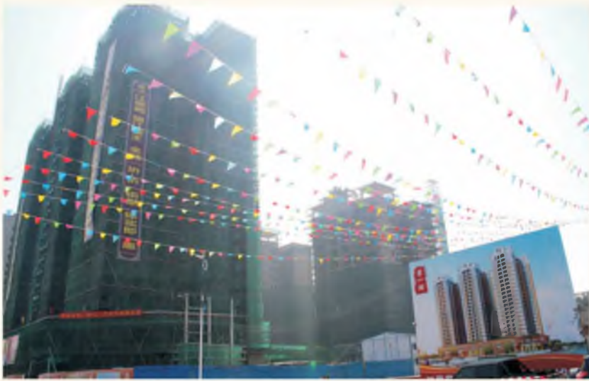
建设中的“三旧改造”项目
