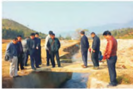
副县长何晓域（左三）检查水利工程建设情况
