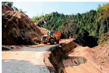
张发奎旅游公路建设现场
