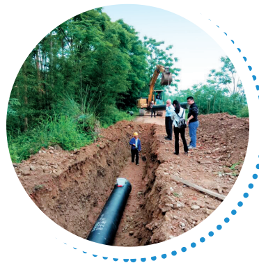
村村通自来水工程施工现场
