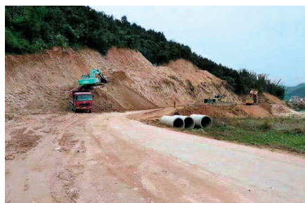
张九龄旅游公路建设现场
